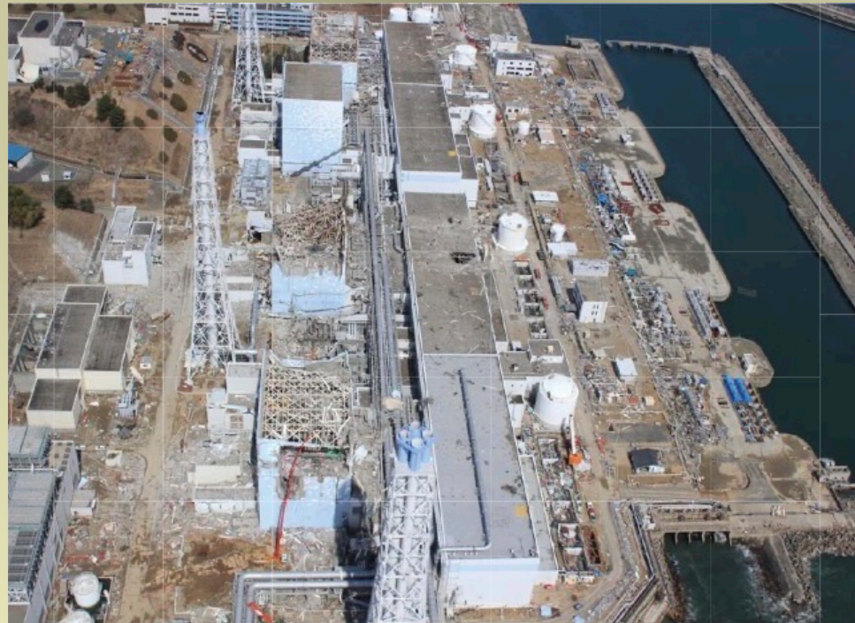
事故発生後の東京電力福島第一原子力発電所 (出典は、東京電力福島原子力発電所事故調査委員会報告書)
