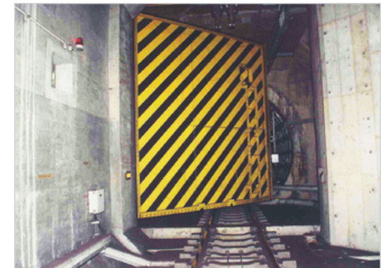
トンネル坑口の防水ゲート(上) 換気口用浸水防止機(下)
