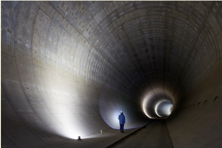
環状七号線地下調節池(洪水調節容量は約54万 \text{m}^3 )の内部(上)と取水口(下)(出典は東京都建設局のHP)
